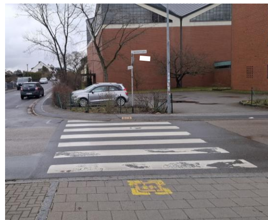
Abbildung 16: Schulwegmarkierung in der Bahnhofstraße in Burghthann
