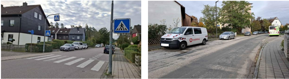
Abbildung 15: a) Fußgängerüberweg Brennerstraße; b) Bushaltestelle Meraner Straße
