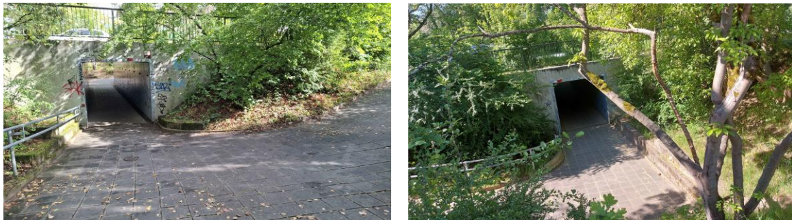
Abbildung 17: a) Foto Unterführung B 8 Südseite; b) Foto Unterführung B 8 Nordseite
